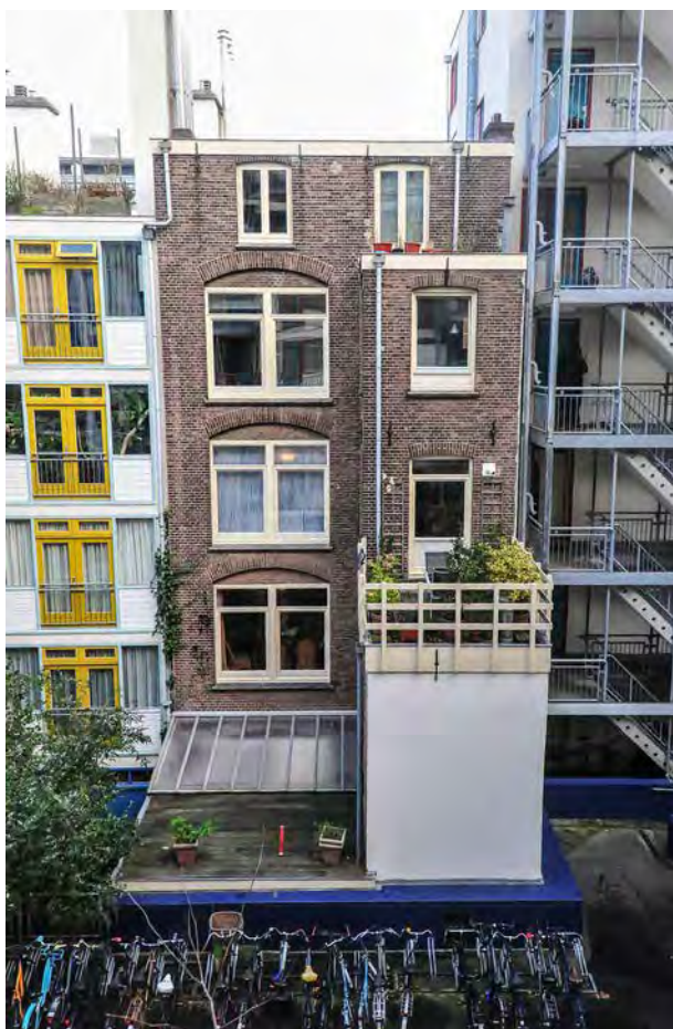
Afb. 13. Achtergevel van het gehandhaafde pand Jodenbreestraat 24. Foto auteurs, 2017.
